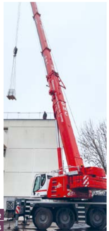
• Isolation et étanchéité des toitures terrasses
