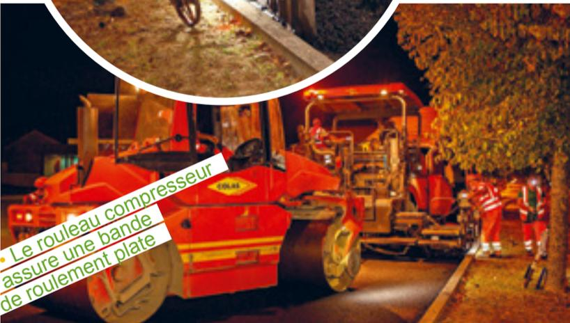
• Le rouleau compresseur assure une bande de roulement plate
